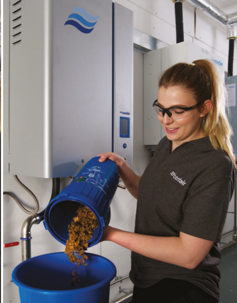
Isıtma elementlerinin üstünde oluşan tortu ayrılır ve kolayca uzaklaştırılabileceği tortu toplama tankına düşer.
